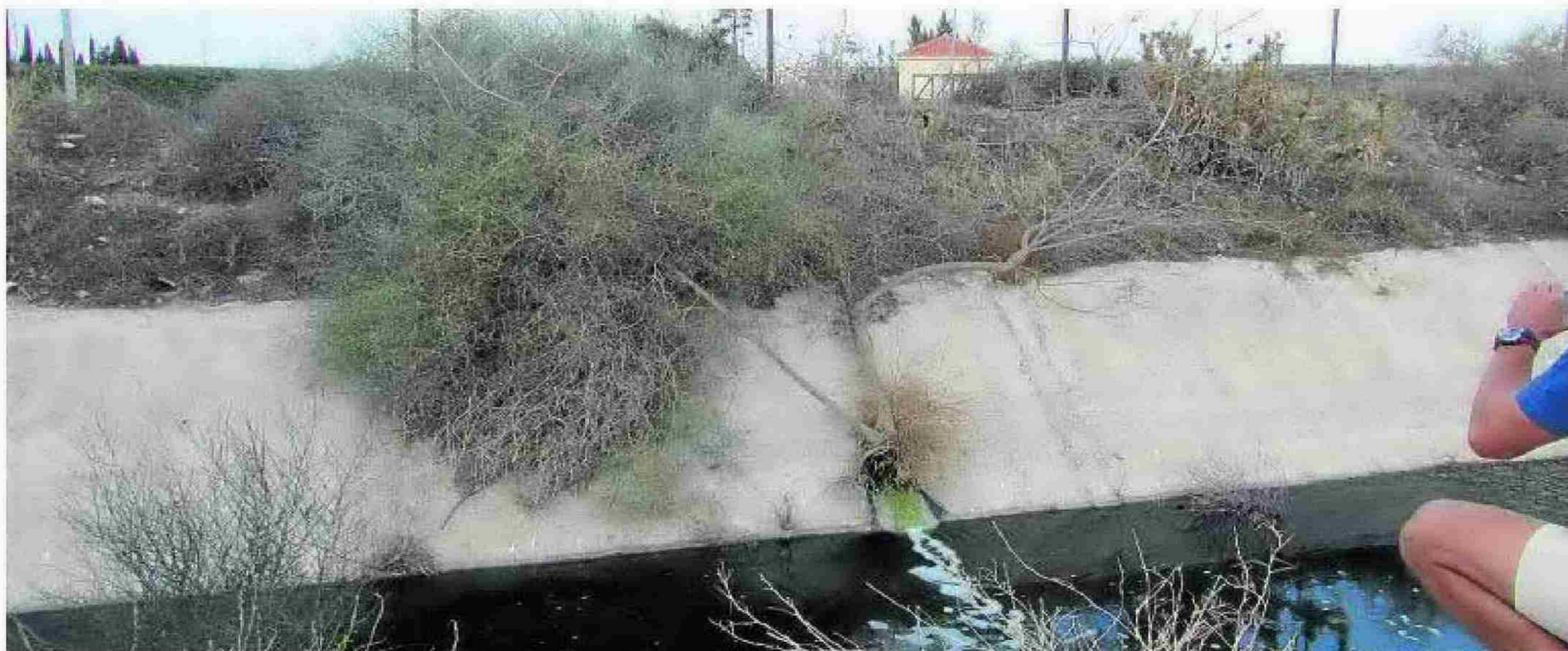
Vertidos desde la EDAR de Villaricos a un cauce que desemboca al río Almanzora y que denuncian como 'dañinos' estos vecinos. :: J. S.
