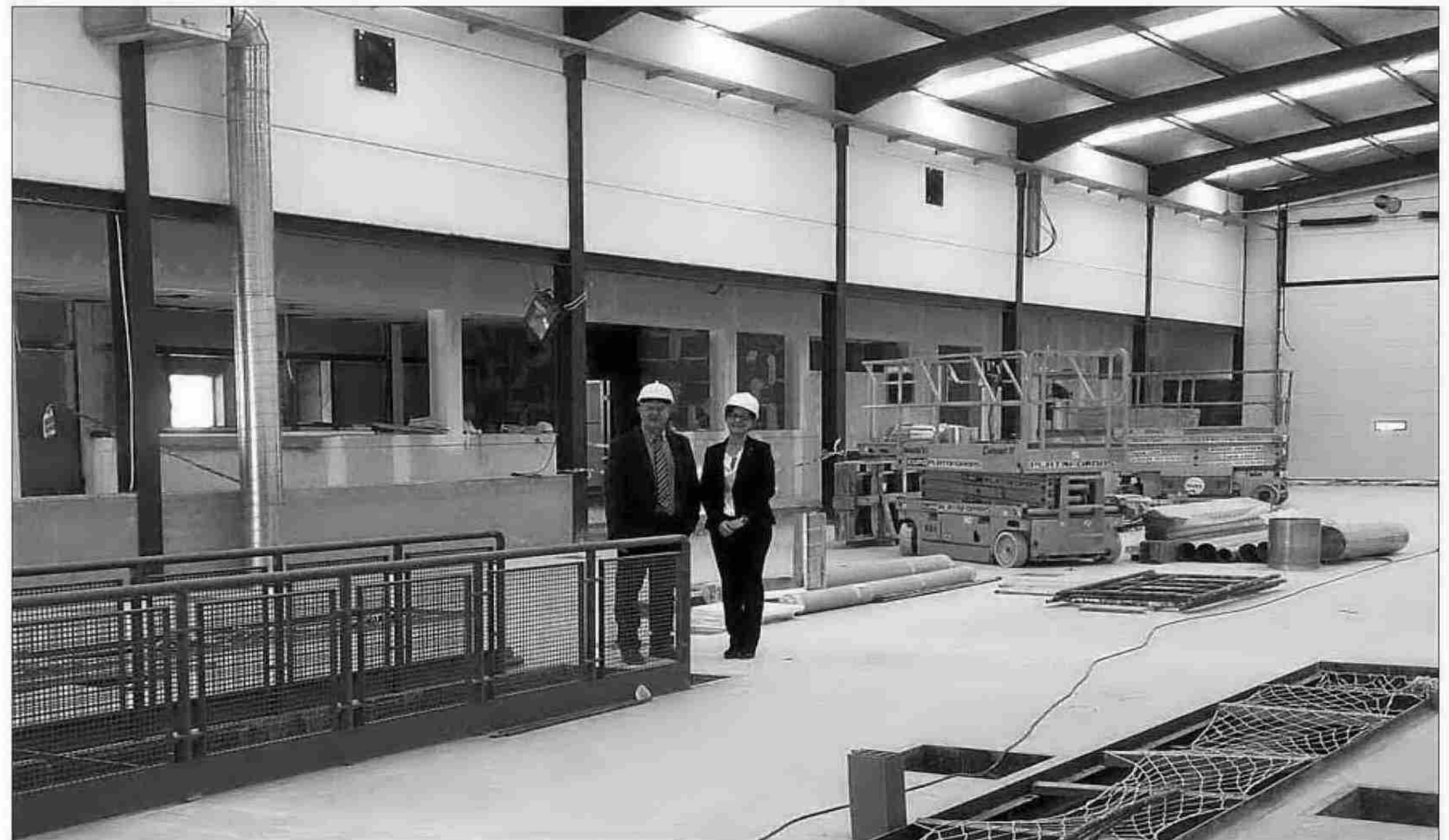
■ Las nuevas instalaciones de ITV en Níjar contarán con dos líneas de inspección. / LA VOZ
