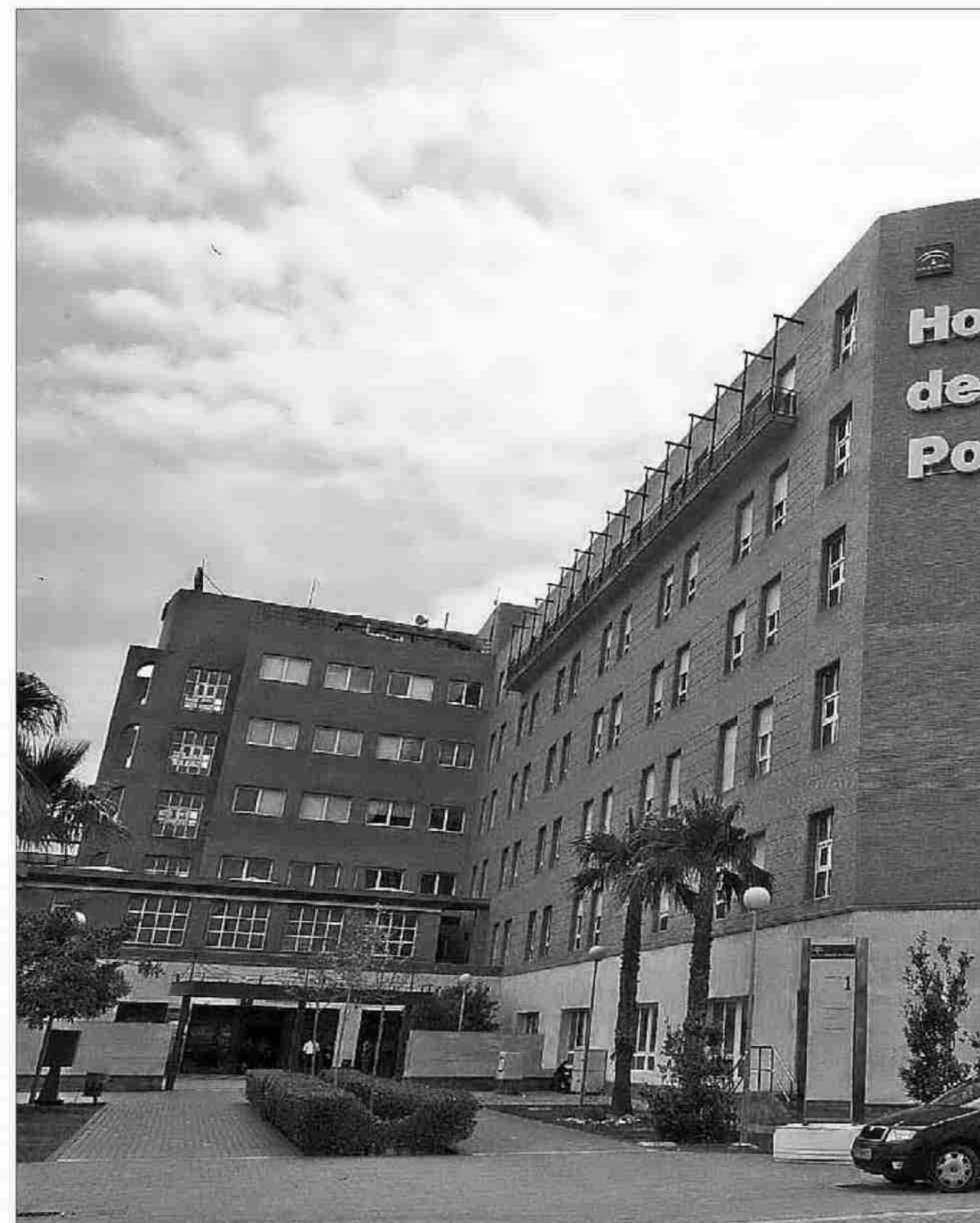
■ Imagen de parte del edificio que conforma el hospital de Poniente, en El Ejido. / LA VOZ
