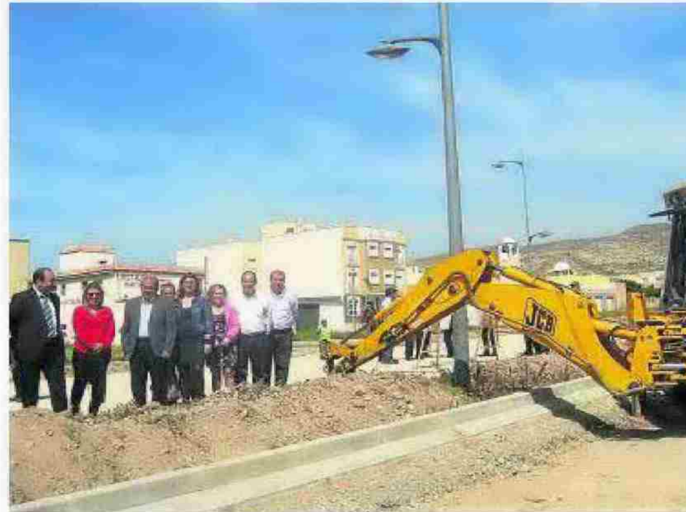
Representantes de la Junta y del Ayuntamiento observan las obras.
