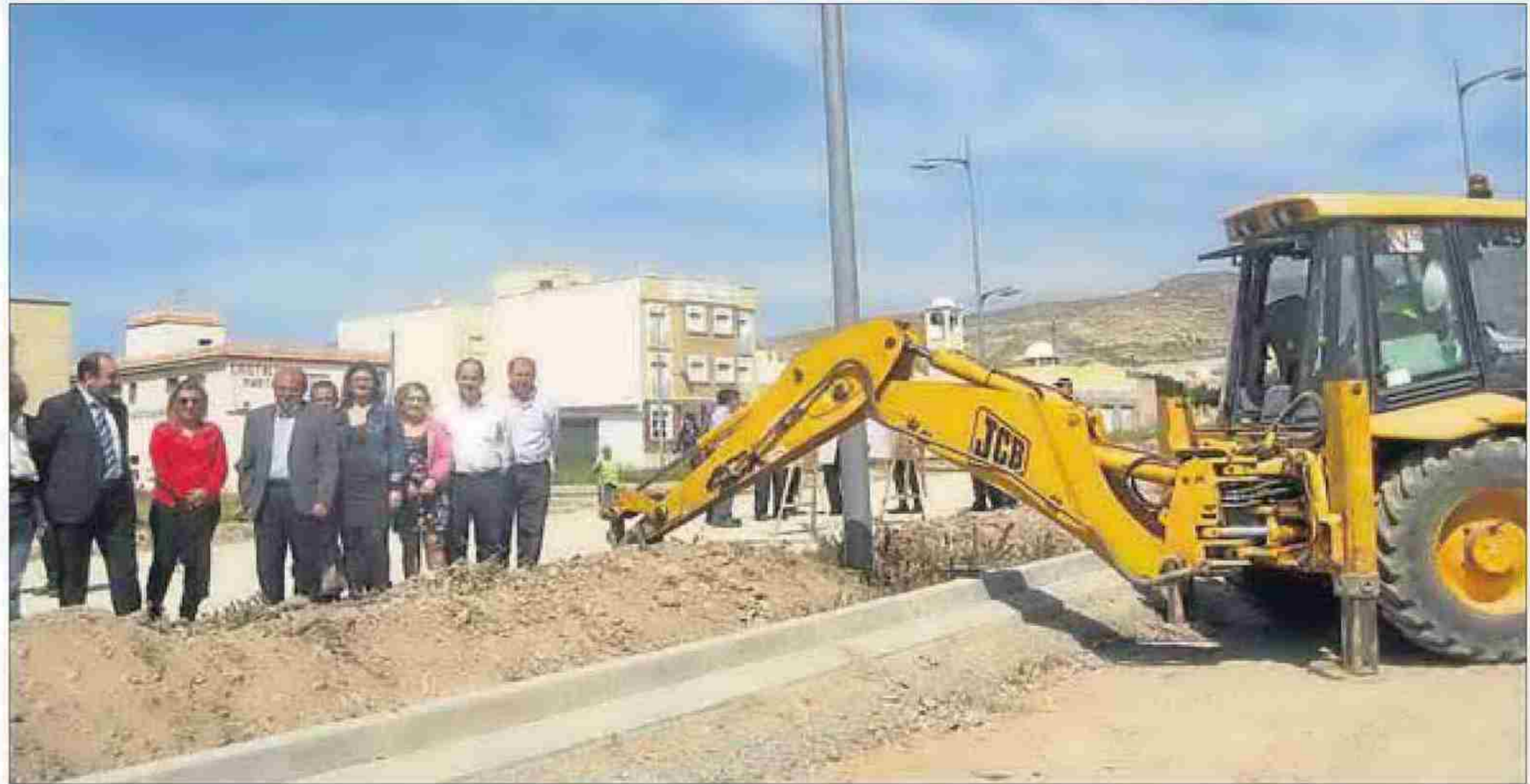
■ Los delegados provinciales y parte del equipo de Gobierno visitaron las obras. / LA VOZ
