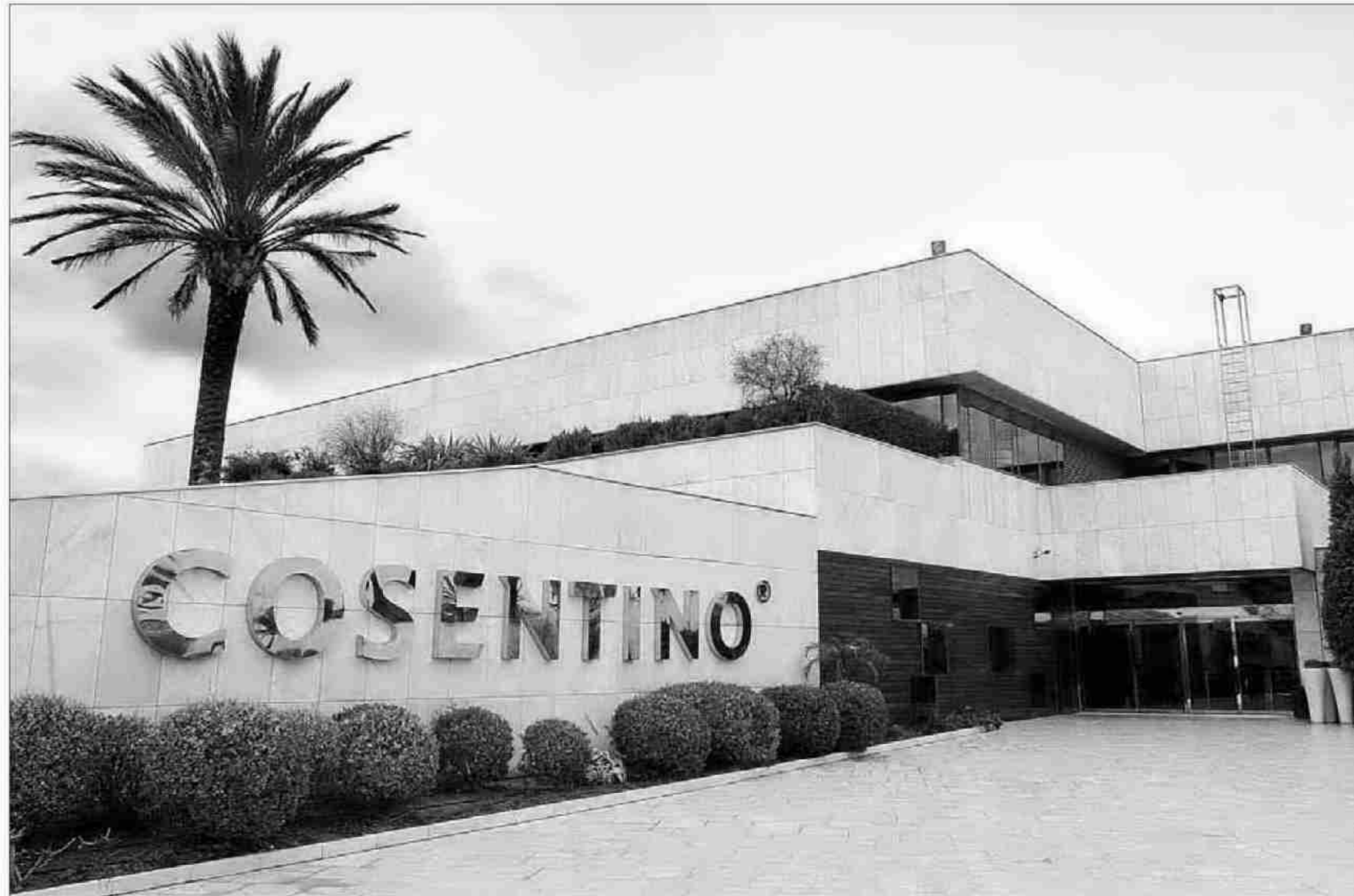
■ La fábrica de Cosentino se convertirá con esta instalación en el principal consumidor de gas natural de Andalucía.
