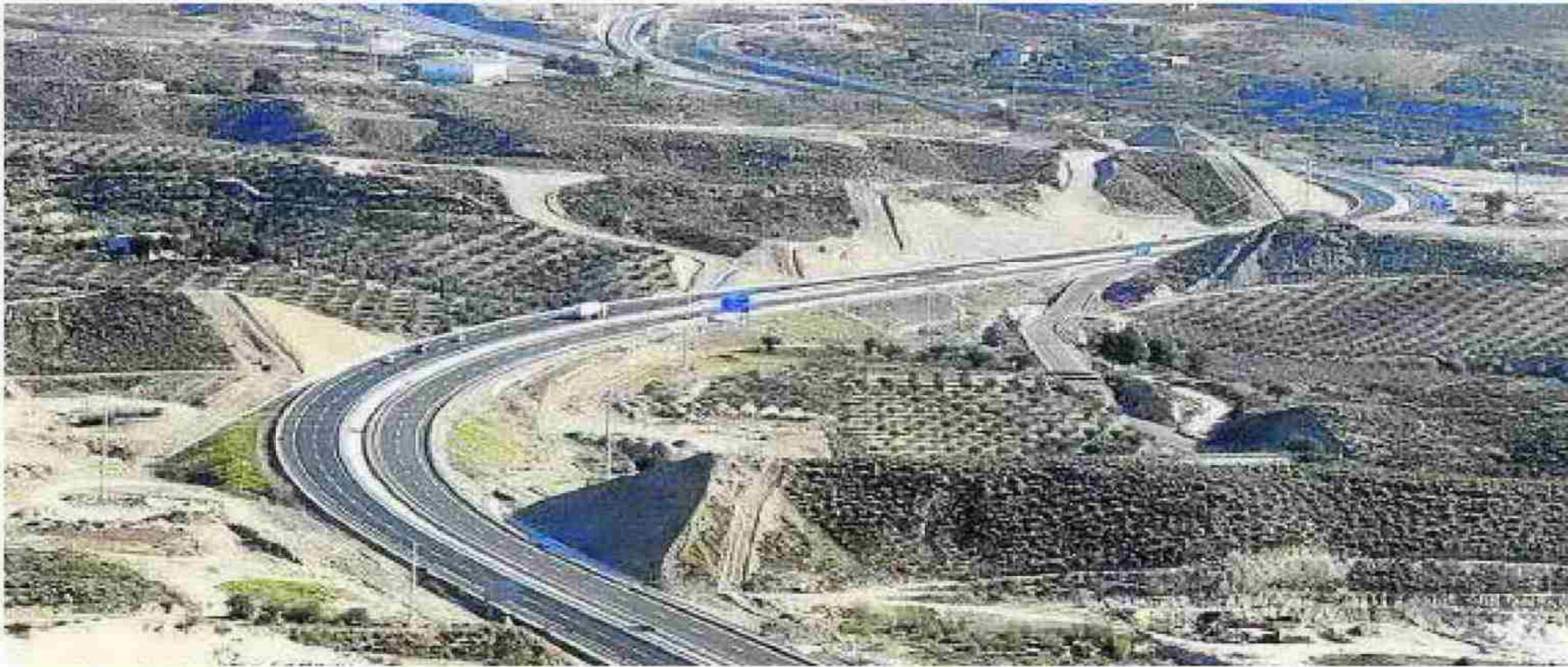
Imagen aérea de la Autovía del Almanzora en los tramos ya abiertos a la circulación.
