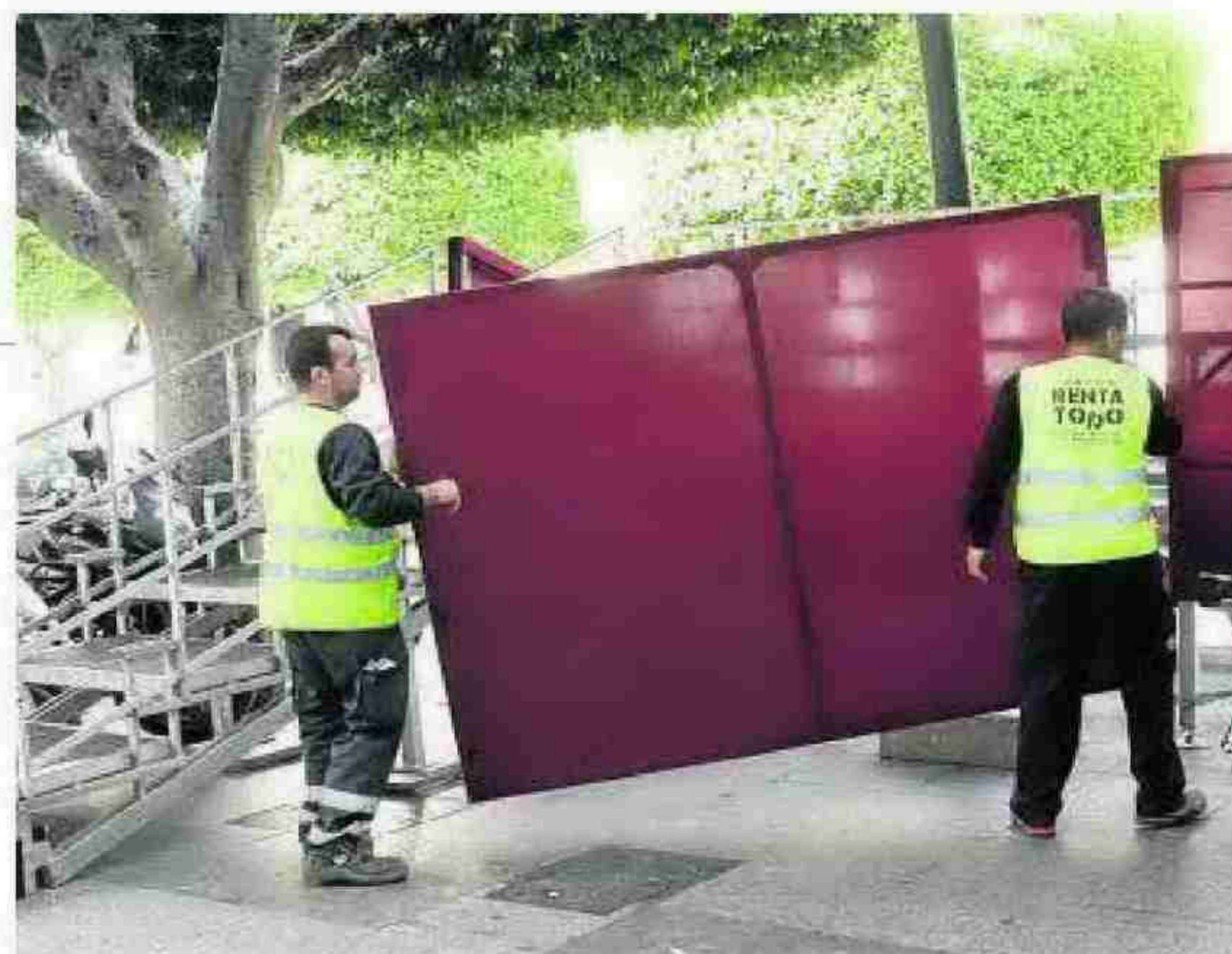
Dos operarios en el montaje de gradas, en la mañana de ayer. :: MULLOR
