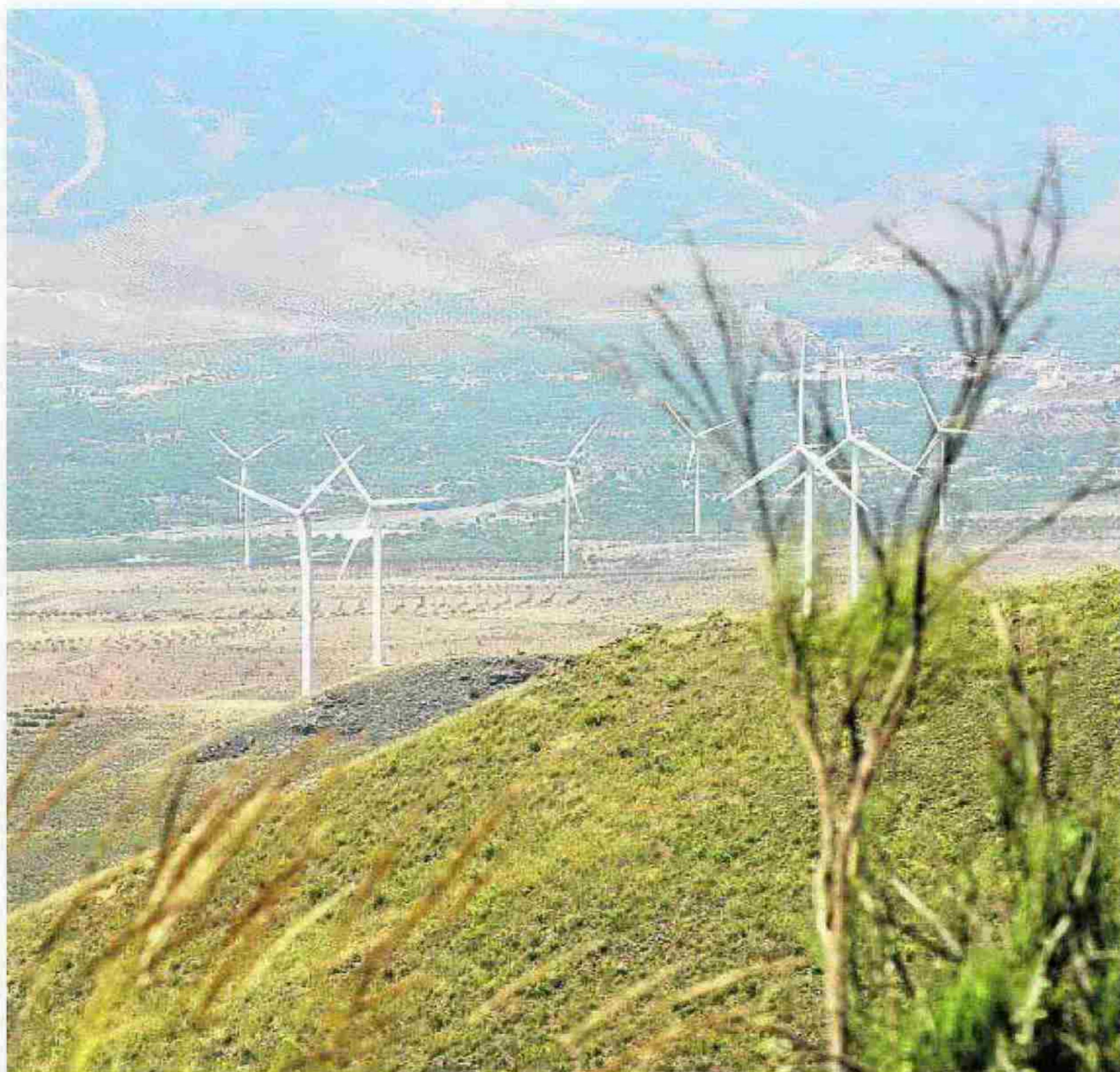
Parque Eólico en la Comarca del Río Nacimiento en la provincia de Almería. ■ J. J. MULLOR
