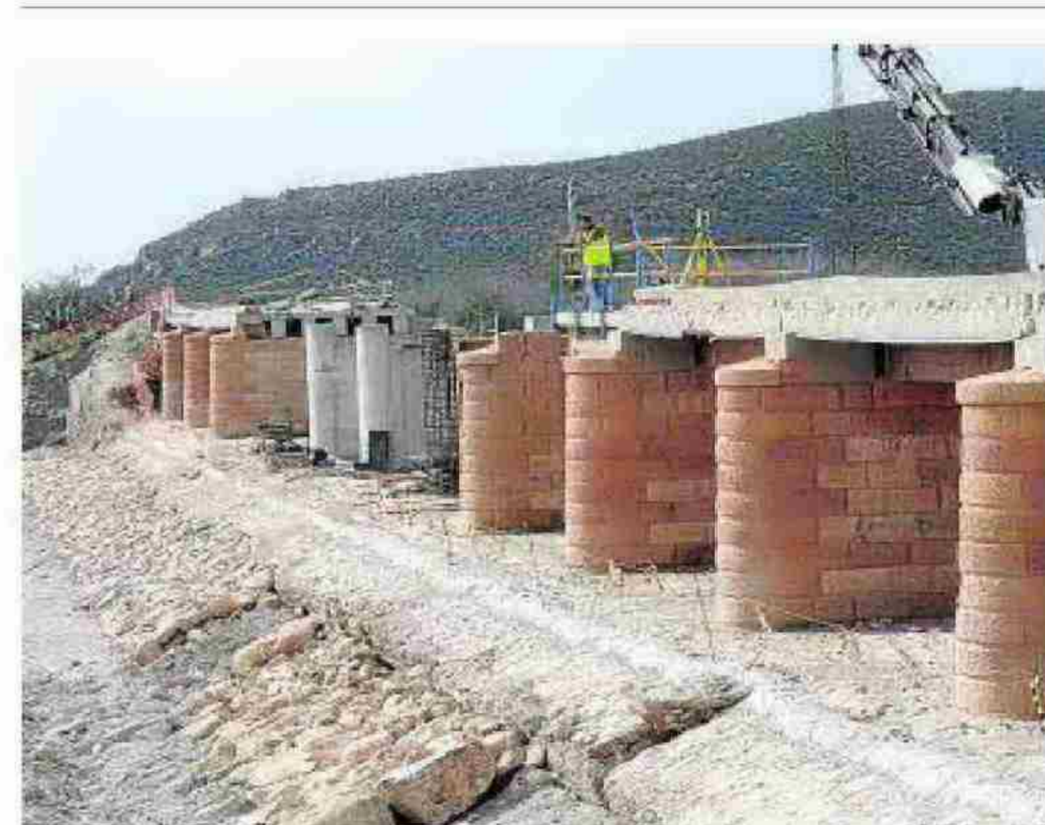
Obras sobre la Rambla de Nogalte para el Cercanías. :: PACO ALONSO
