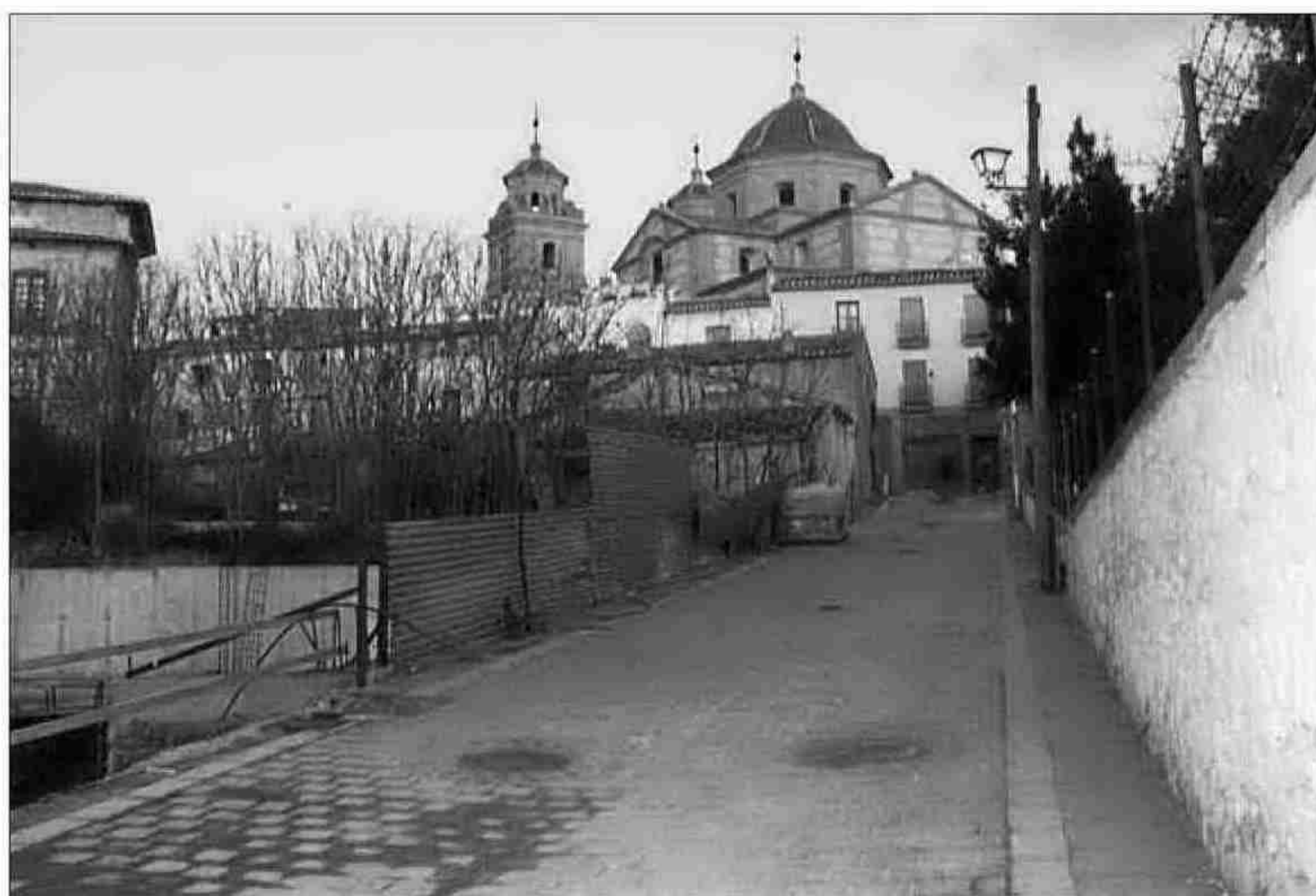
■ Obras de adoquinado en la calle Reynas. / A. CRISOL
