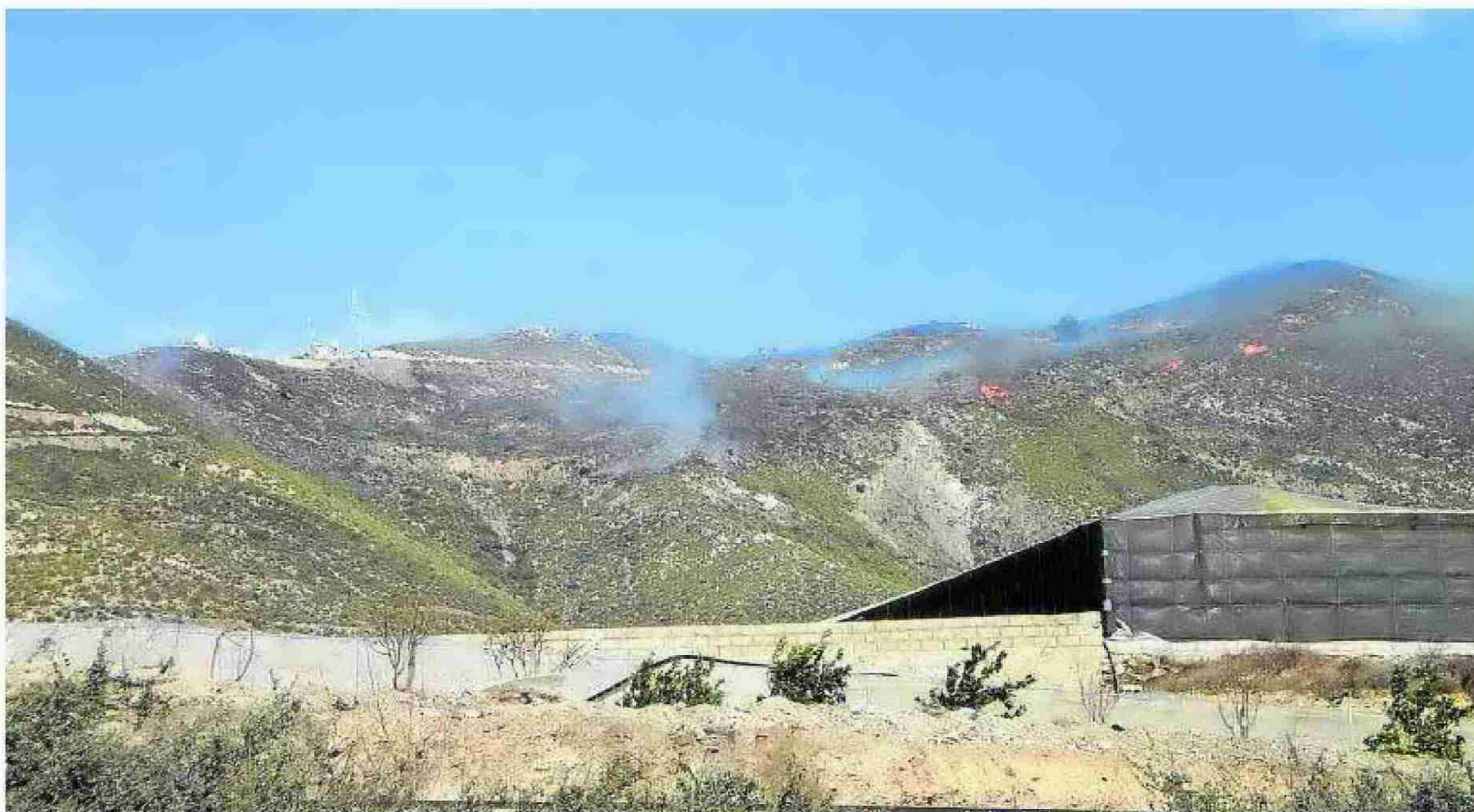
El fuego en el monte afectó a algunos transformadores y se cortó el suministro eléctrico que abastece a los repetidores. :: A. P.
