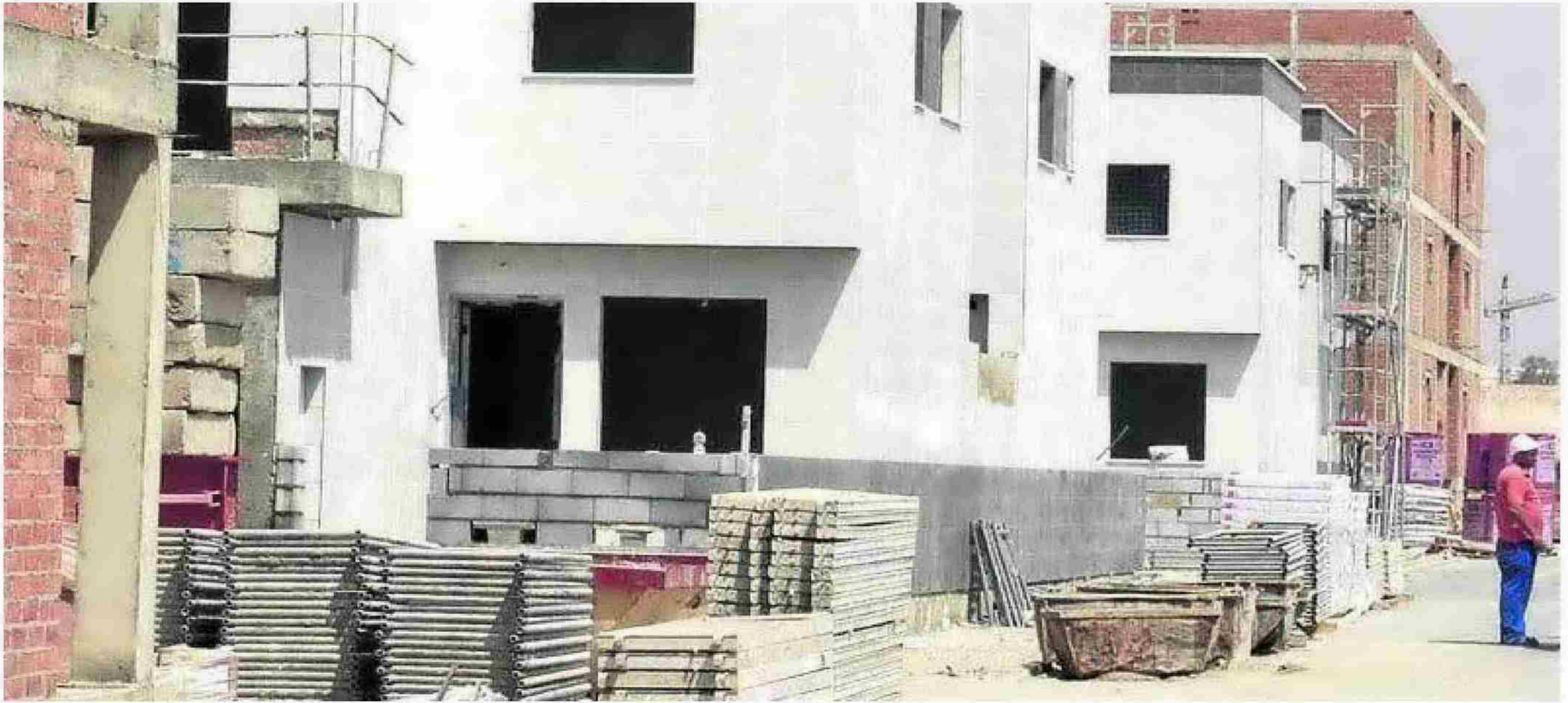
Obras de construcción en una promoción de viviendas de VPO en la capital. :: IDEAL
