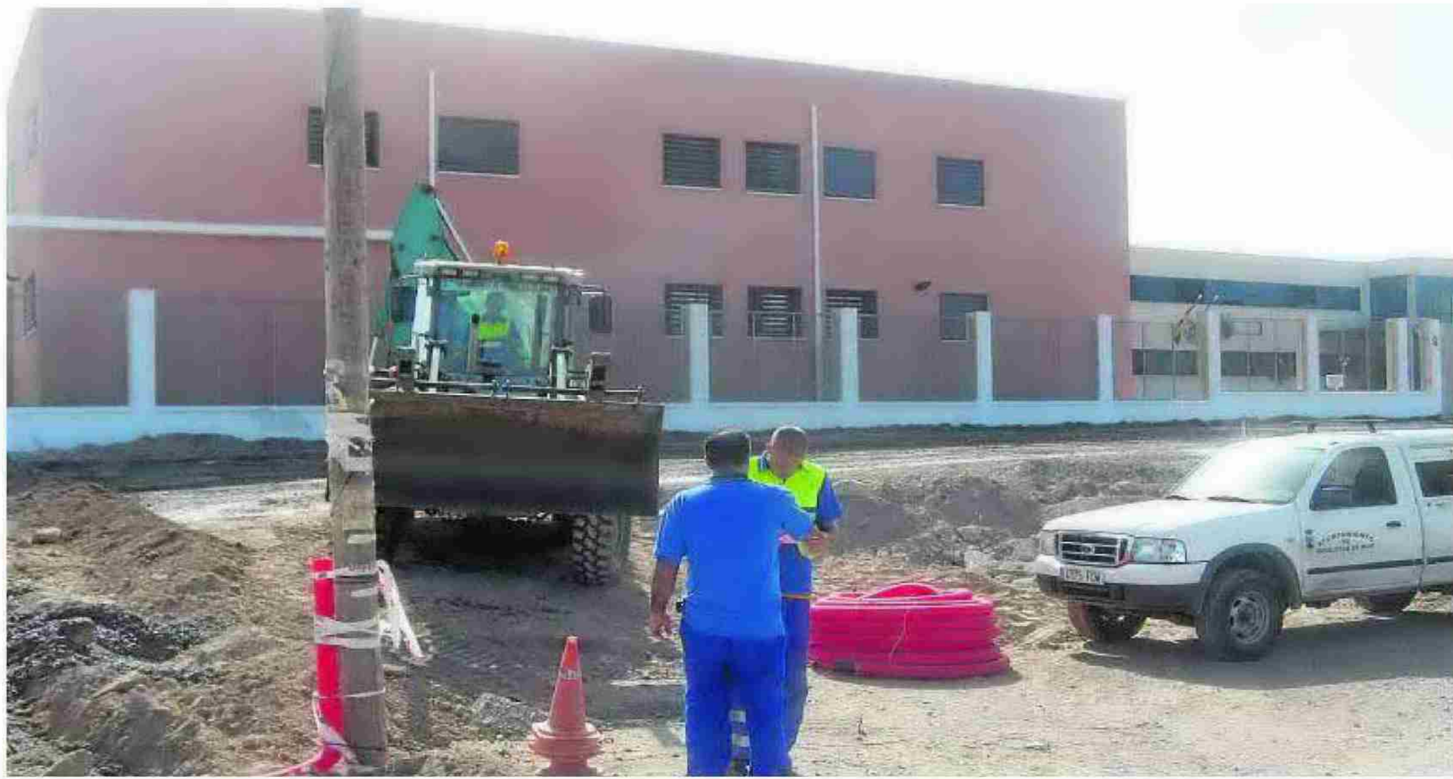
El IES Las Marinas se encuentra en una zona solitaria, en la que los niños son dejados todavía de noche, sin supervisión. :: VALDIVIA
