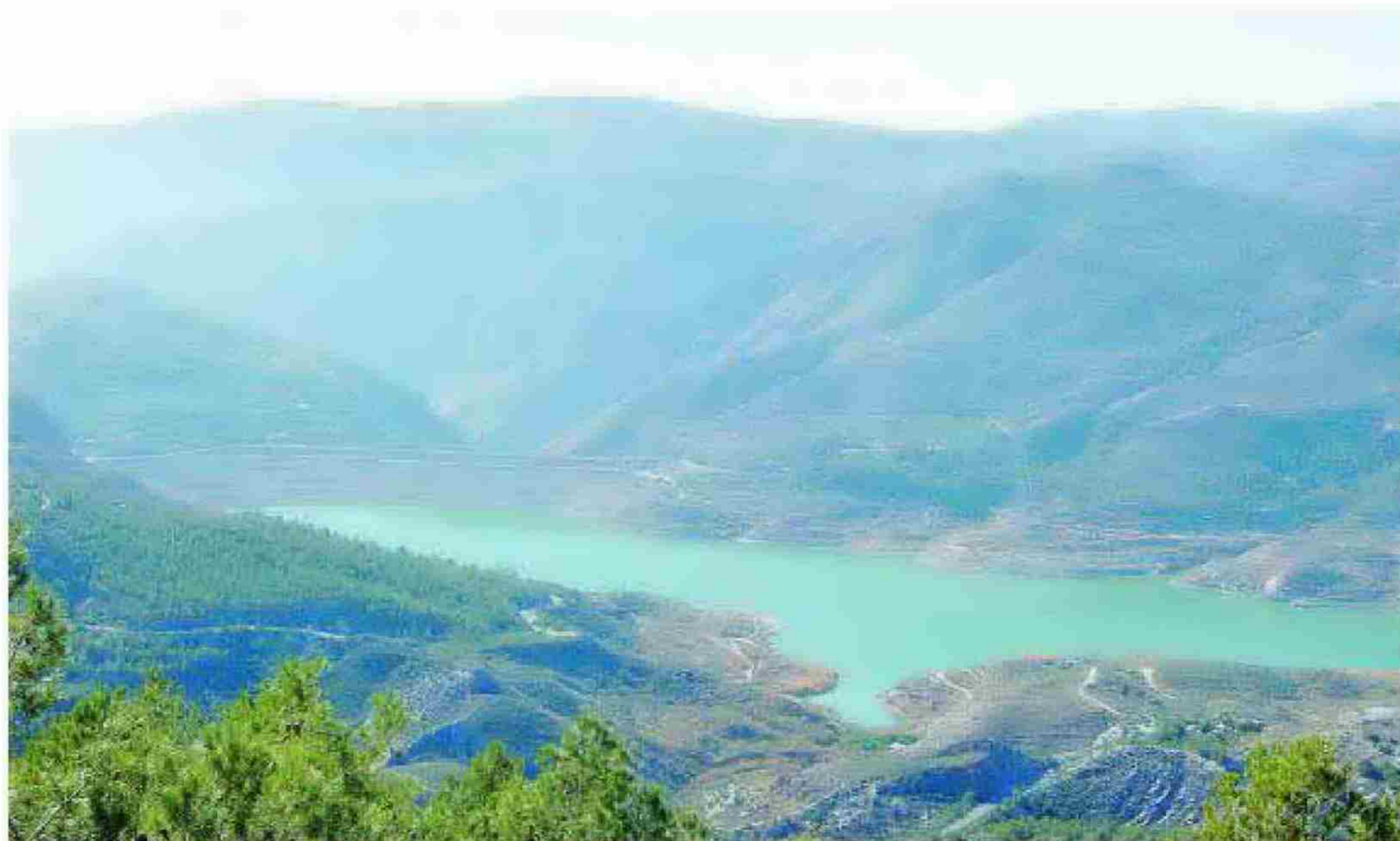
Vista del agua embalsada en el pantano de Benínar donde se realizarán obras de mejora. :: IDEAL
