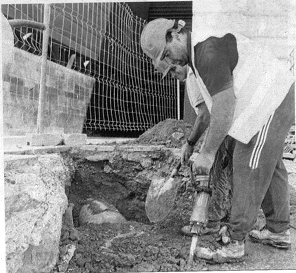
Un obrero hace unos trabajos en una calle.
